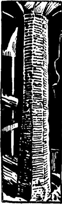
Фиг. 25. Железо-бетонная стойка со спиральной оболочкой, освобожденная от верхнего бетонного слоя.
