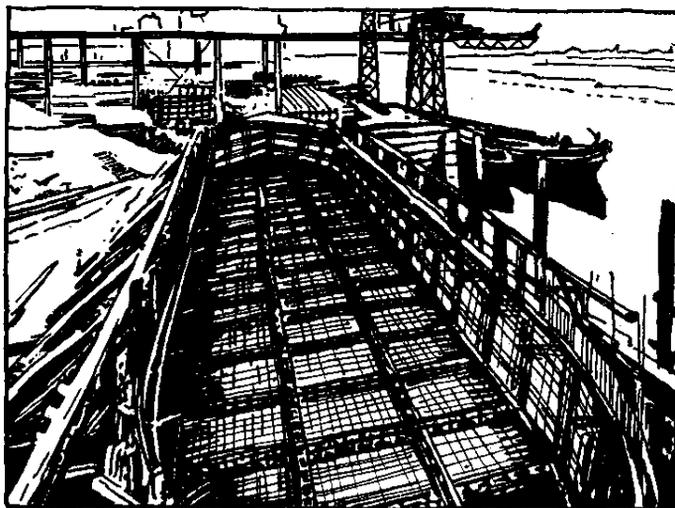
Фиг. 100. Железо-бетонная баржа в постройке. Укладка арматуры.
