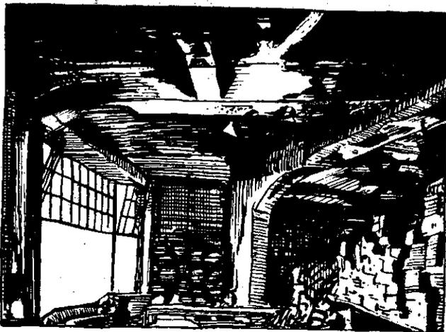
Фиг. 9. Вид жел.-бет. потолка в здании Эсдерс в Дрездене после пожара. Белые пятна след струи пожарного насоса.
