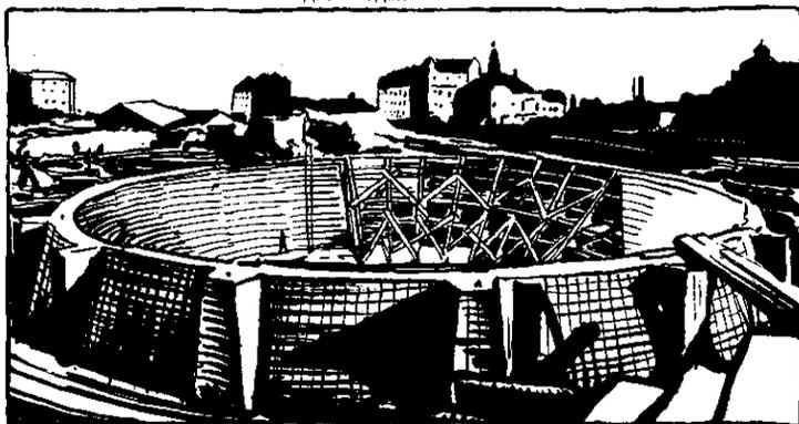
Фиг. 48. Нижняя часть железобетонного резервуара-газометра во Фрейбурге; диам. 36,5 м., глуб. 8 м., объем 8000 куб. м.
