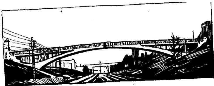
Фиг. 120. Жел.-бетонный мост на выставке в Лейпциге по системе Эмпергера с применением чугунных сердечников.
