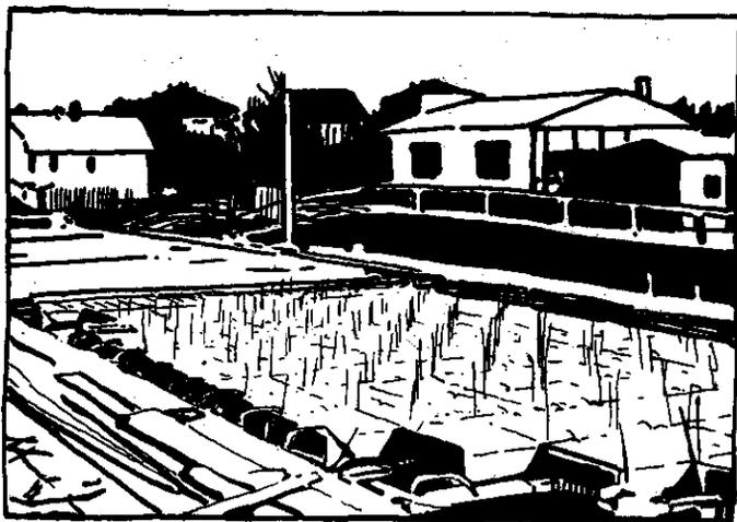
Фиг. 27. Железо-бетонное перекрытие с пустотами для облегчен. общего веса.
