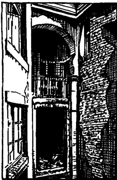
Фиг. 11. Обвалившийся от действия огня штукатурный намет во дворе того же здания. Железо-бетонная перемычка от огня не пострадала.
