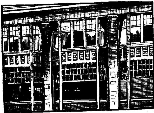
Фиг. 8. Железо-бетонный корпус фирмы Эсдерс в Дрездене после пожара 1911 г.
