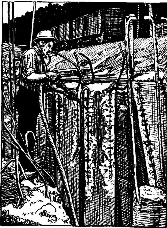
Фиг. 17. По мере надобности может производиться наращивание железобетонных свай или их укорочение.
