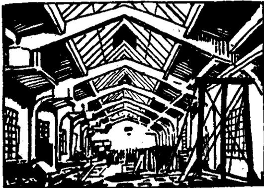
Фиг. 65. Железо-бетонная рамная конструкция, примененная для перекрытия фабричного корпуса.
