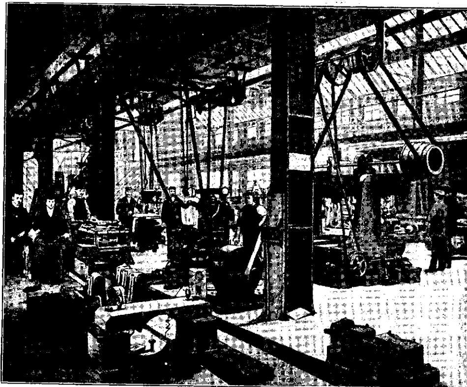
354. Электродвигатели в машинном отделении завода.
