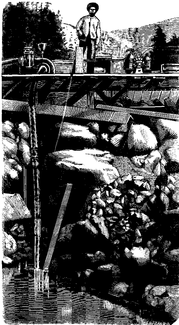
357. Водоотливная установка съ электрическимъ двигателемъ.
