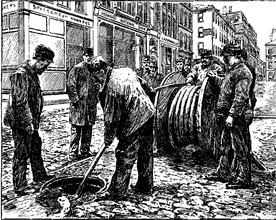
778. Спускание кабеля въ трубу.
