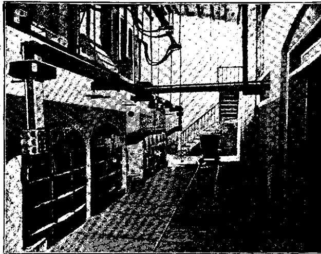
523. Электрические печи завода кальция-карбида у Ниагарского водопада.
