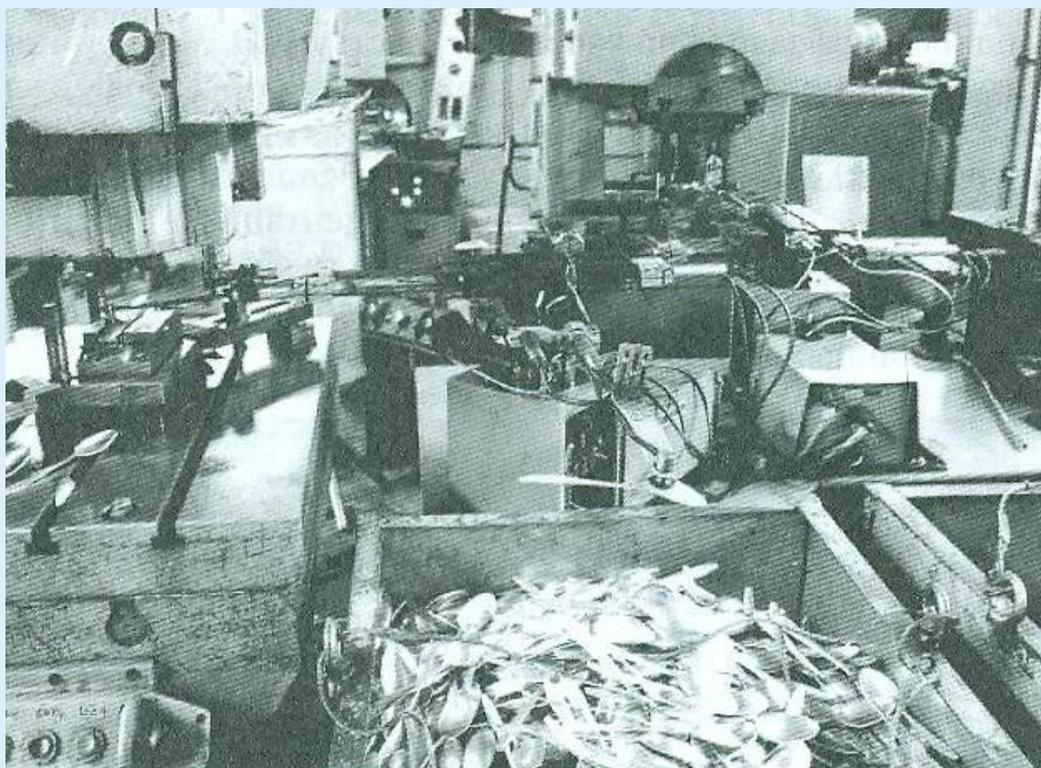
*С помощью такого робота-манипулятора изготавливали ложки.*
