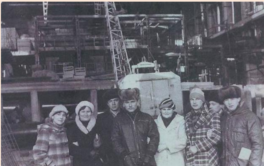
Студенты группы ЭСТ-80 во время экскурсии на Ново-Иркутской ТЭЦ (монтаж турбогенератора № 5, 1984 год).
